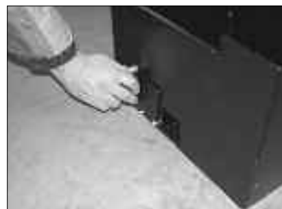
Bild D-14.6: Brennerklappe 1,5-3 cm offen
